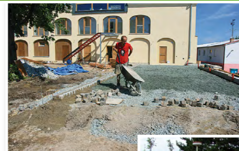
Rekonstrukce záměčku na ekocentrum Trkmanka
