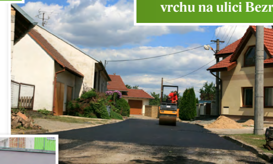
Pokládání asfaltového povrchu na ulici Bezručova
